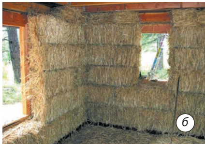
Мал. 1.3. Використання природних матеріалів у будівництві екологічного житла: а — солom'яний блок; б — стіновий каркас із соломи; в — дах з очерету
