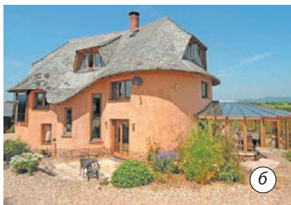
Мал. 1.4. а — саман; б — зовнішній вигляд будинку із саману; в — внутрішні поверхні оброблені глиною
