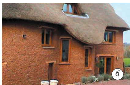
Мал. 1.18. Використання саману: а — кладка стіни із саману; б — будинок із саману; в — дизайнерські рішення облаштування печі із саману
