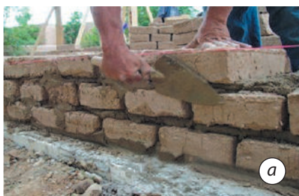
Мал. 1.18. Використання саману: а — кладка стіни із саману; б — будинок із саману; в — дизайнерські рішення облаштування печі із саману
