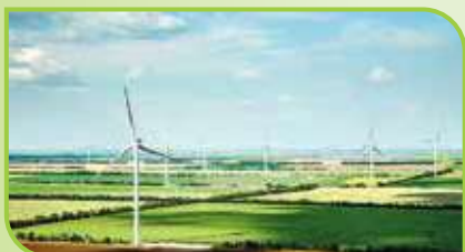
Мал. 123. Ботіївська вітрова електростанція
