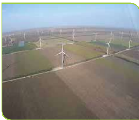
Ботіївська вітрова електростанція
