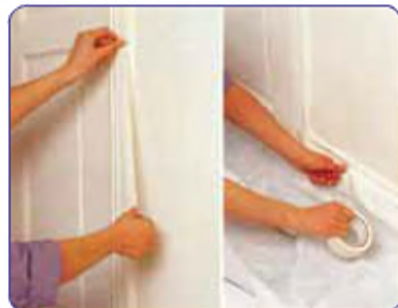
Мал. 177. Закривання поверхонь та підлоги за допомогою малярної стрічки
