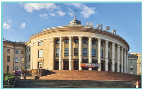
Національний цирк України. Сучасна будівля. Київ
